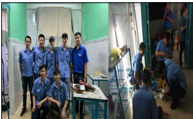
LẮP ĐẶT ĐIỆN CHO GIA ĐÌNH CÓ HOÀN CẢNH KHÓ KHĂN
